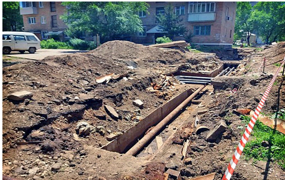
капитальный ремонт более 2 км тепловых сетей
